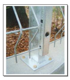
Бетонная доска с промежуточным соединителем
