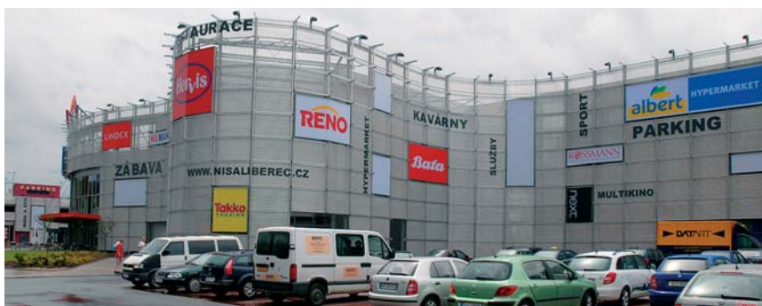
элементы фасада и облицовка стен из ПВЛ – торговый центр Либерец
