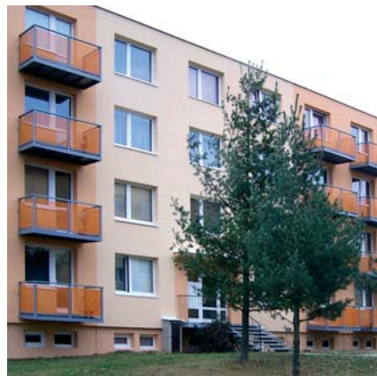
балконы жилых домов
