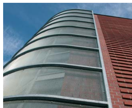
защитный декоративный экран пожарных лестниц и лифтов
